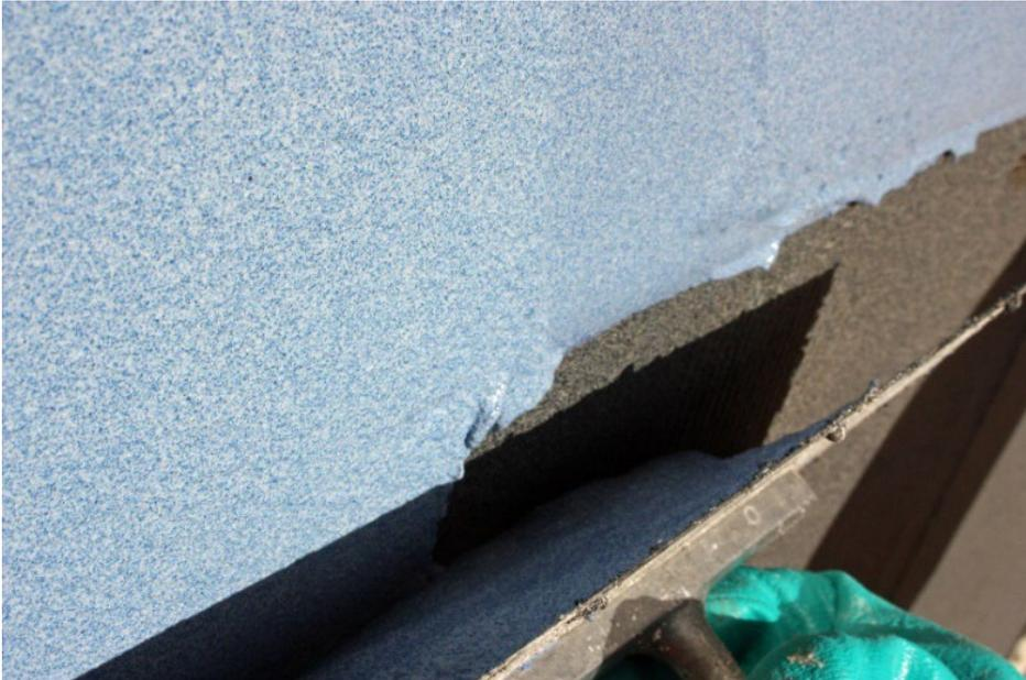
MB 1K rapid und MB 1K S erfüllen als 1K Flexible Polymermodifizierte Dickbeschichtung (FPD) alle Anforderungen an die schnelle und sichere Bauwerksabdichtung.
